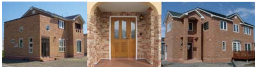
※写真はすべて十勝管内施工実例
